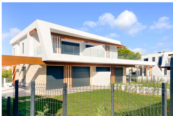
Blick auf eine der Villen
