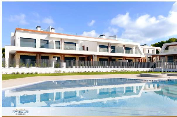
Blick auf die Anlage
