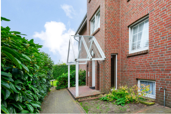
Blick auf den Hauseingang
