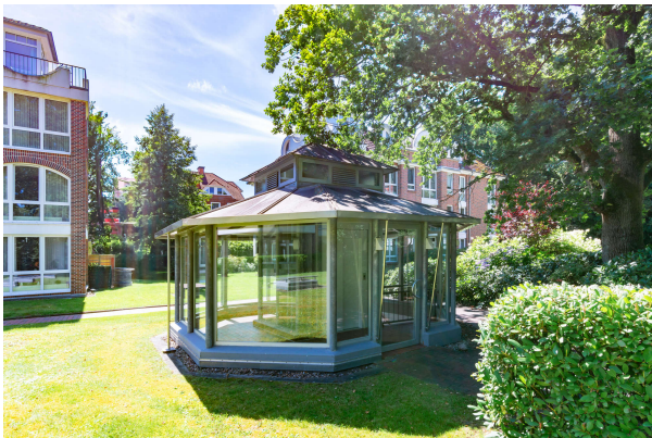
Zugang zur Tiefgarage
