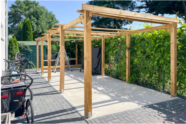
Carport (noch im Bau)
