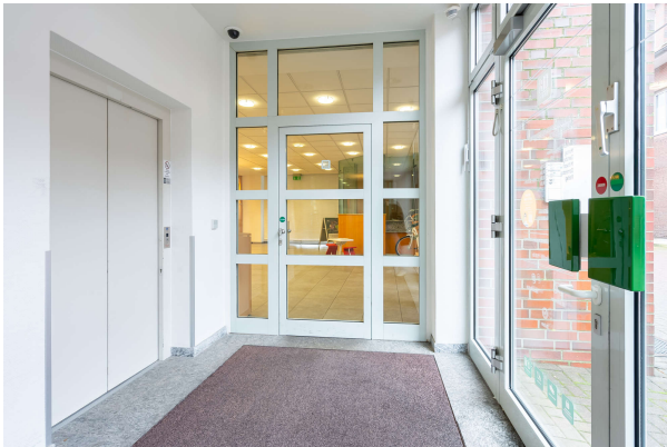
EG: Seiteneingang mit Fahrstuhl
